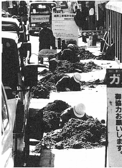
写真20-5-3 懸命の復旧作業
