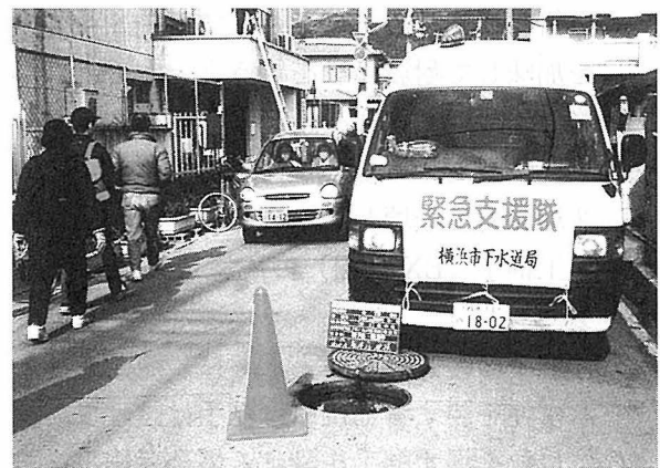
写真20-2-5 大都市の管路施設被害調査支援隊の作業状況（東灘区）
