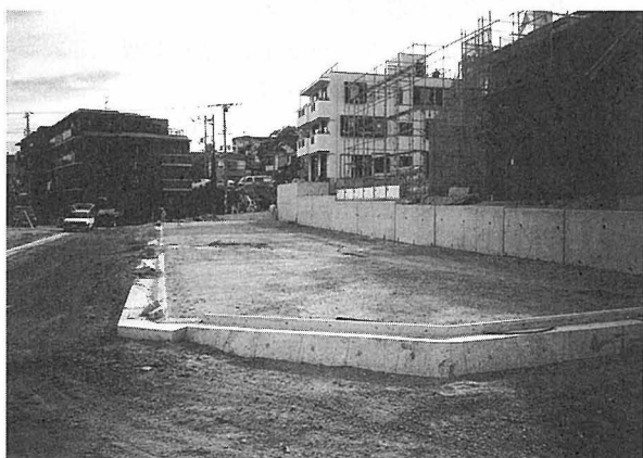
写真21-10-1 区画整理事業による街路、擁壁等の築造 (松本地区)
