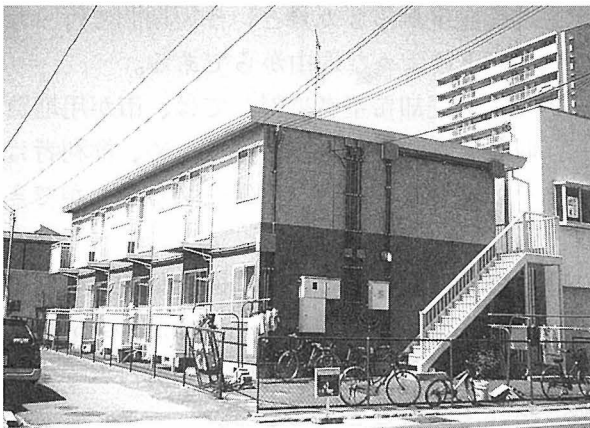
写真21-4-1 事業用仮設住宅（御管西地区）
