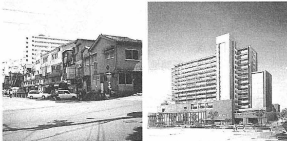
従前状況 従後状況 写真21-18-7 湊川中央周辺地区
