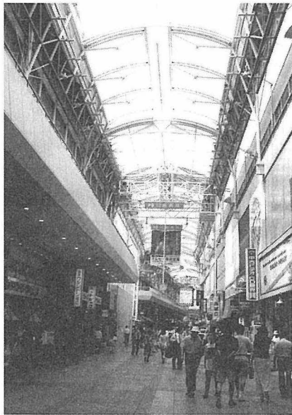
写真21-14-12 センター街アーケード（再建後）
