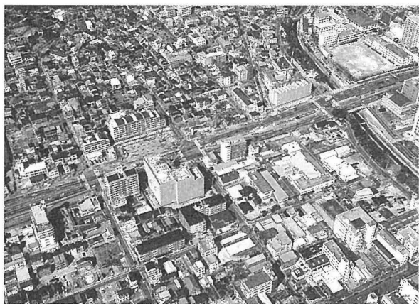
写真21-17-15 大道周辺地区の復興状況 (H11.2)
