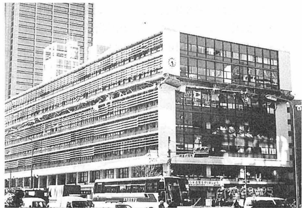
写真21-14-1 市役所被災状況
