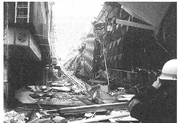
写真21-14-2 センター街被災状況
