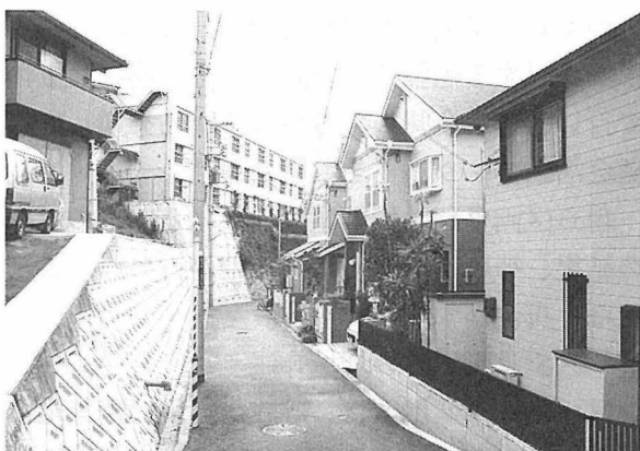
写真21-17-18 復旧した私道（南側）と沿道の住宅
