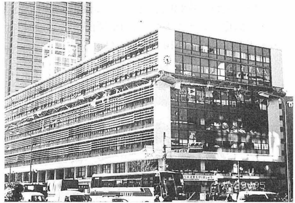
写真21-14-1 市役所被災状況
