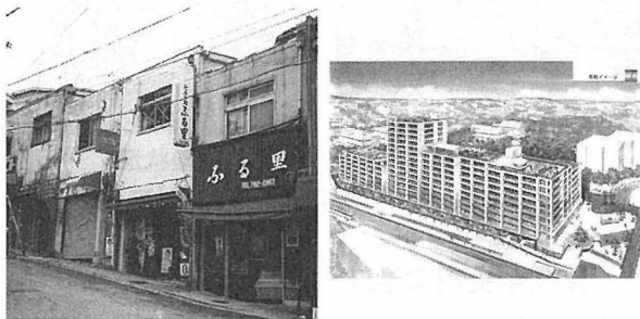
従前状況 従後状況 写真21-18-8 舞子公園駅北地区
