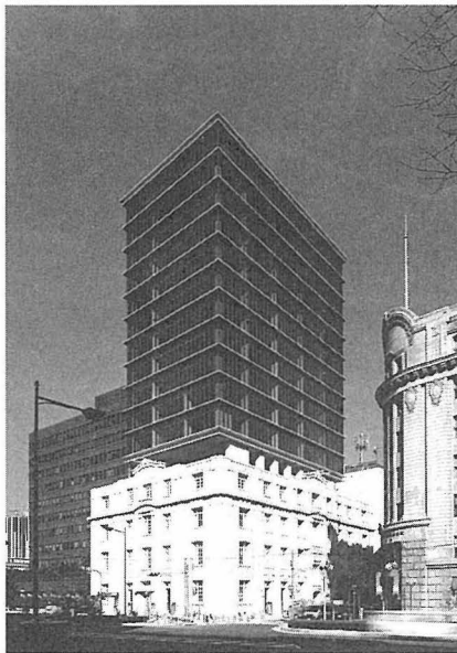
写真21-14-9 海岸ビル（再建後）
