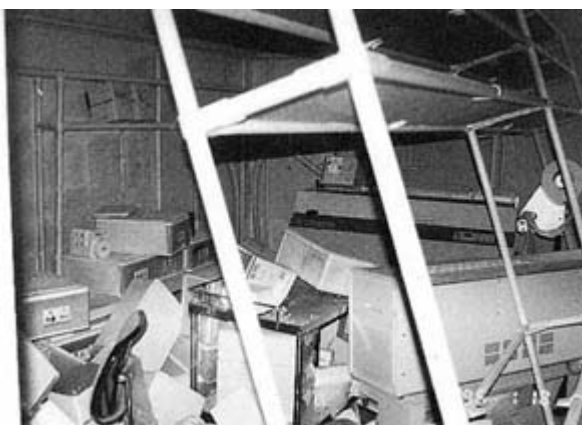
薬局「薬品制より殆ど落下散乱、生薬分包器傾斜、工キス剤分包器変位」（平成7年1月18日撮影）
