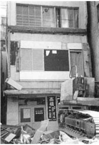
解体直後の写真です。元々鉄筋コンクリート3階建に増築という形でガレージを改造して建増したものですので、本館がどの位傷んでいるか気になっていたのですが、幸いなことにこれが一部損傷程度で残っていました。殆ど奇跡です。正面の建物がそれです。
