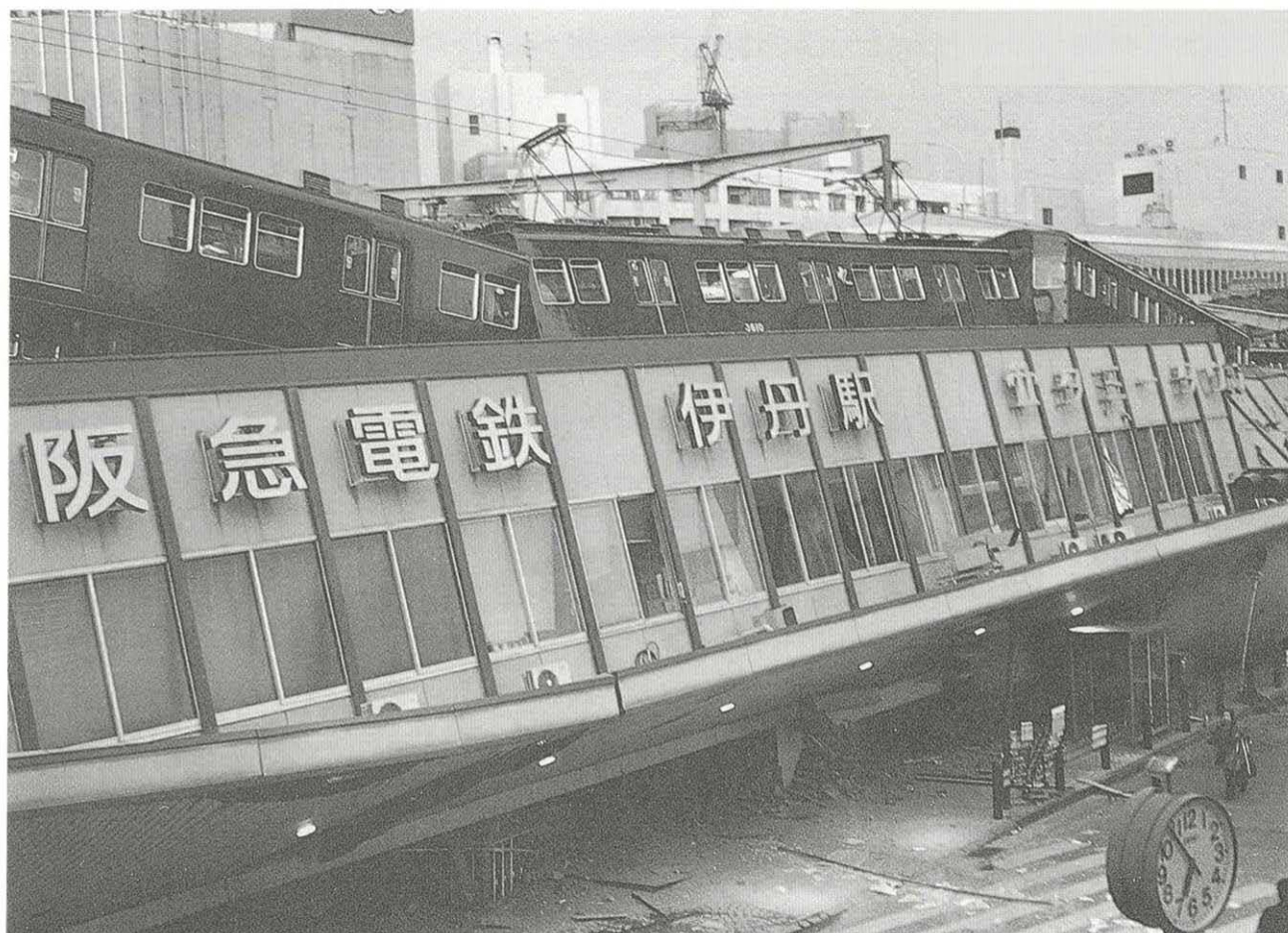
▼阪急伊丹駅倒壊 ●浜屋 伊丹店 前80m
