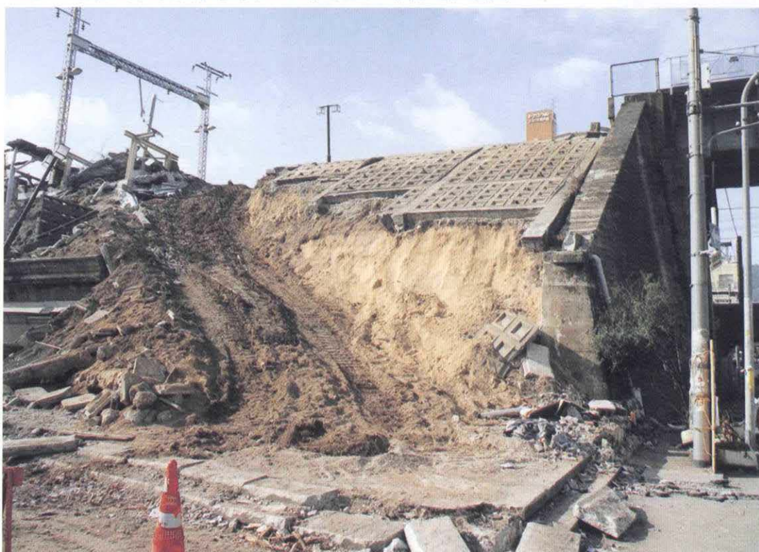
▼JR新長田駅倒壊 ●浜屋 新長田店 より北へ100m
