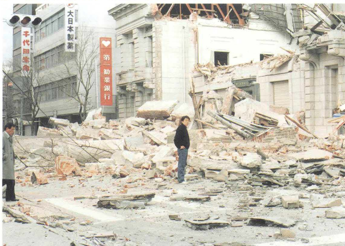
▼第一勧業銀行神戸支店倒壊 ●浜屋 神戸本店より南東へ約150m
