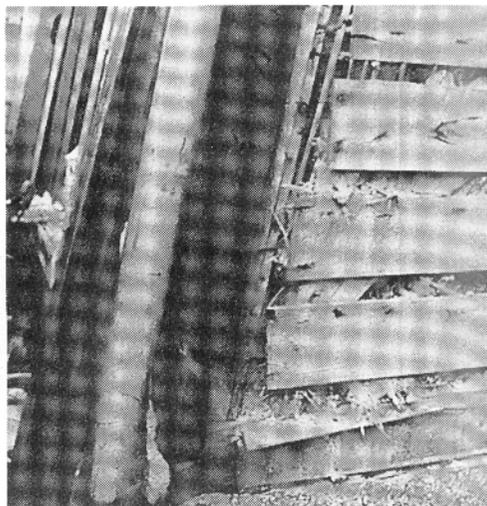
写真8 釘2本斜め打ちの接合部が抜けてしま
