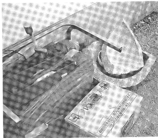
写真10 落下して壊れた石臼と水槽.
