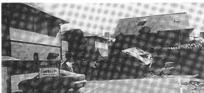
写真9 倒壊した重い瓦屋根と土塗壁の古い住宅、そして、被害を免
