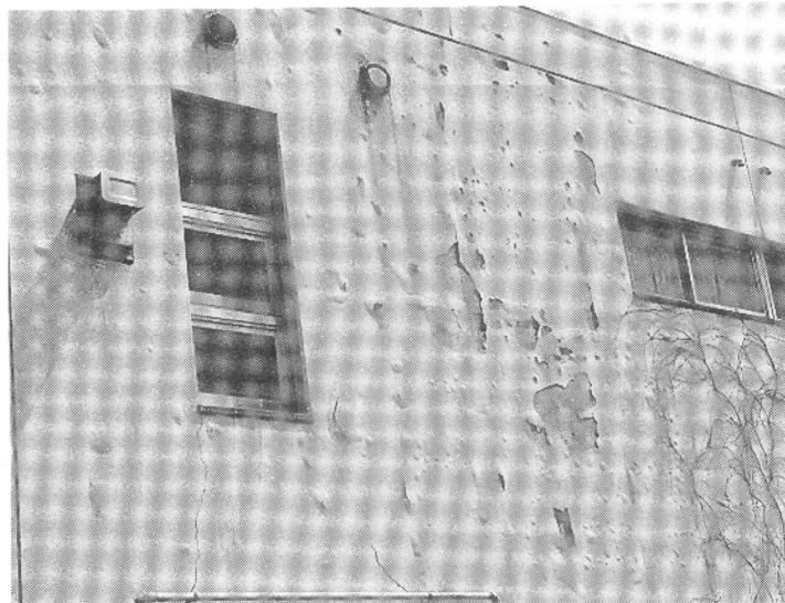
写真2 保育所の外壁，輻射熱で火ぶくれに。
