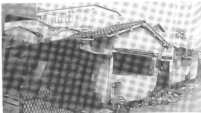
写真7 大きな開口部をとった後ろ側が大変形し、
