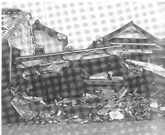
写真3 珠洲市内の完全倒壊した土蔵
