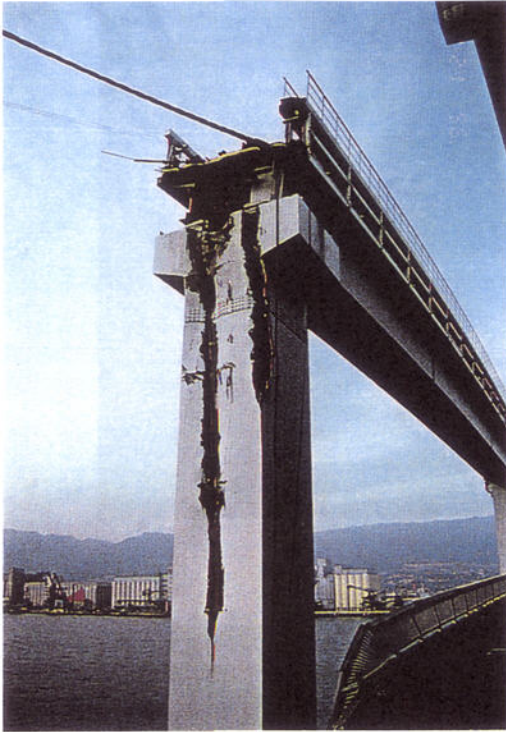
J. 神戸新交通六甲アイランド線六甲大橋南側
