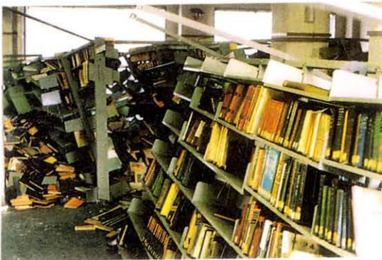
損壊したスチール書架 上部連結と床固定をしていたスチール書架が、ねじれるように損壊した。
