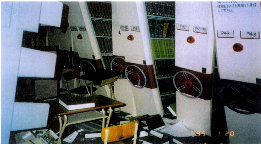
傾斜した集密書架 手動式集密書架がレールと直角方向に傾斜し、作動不能となった。
