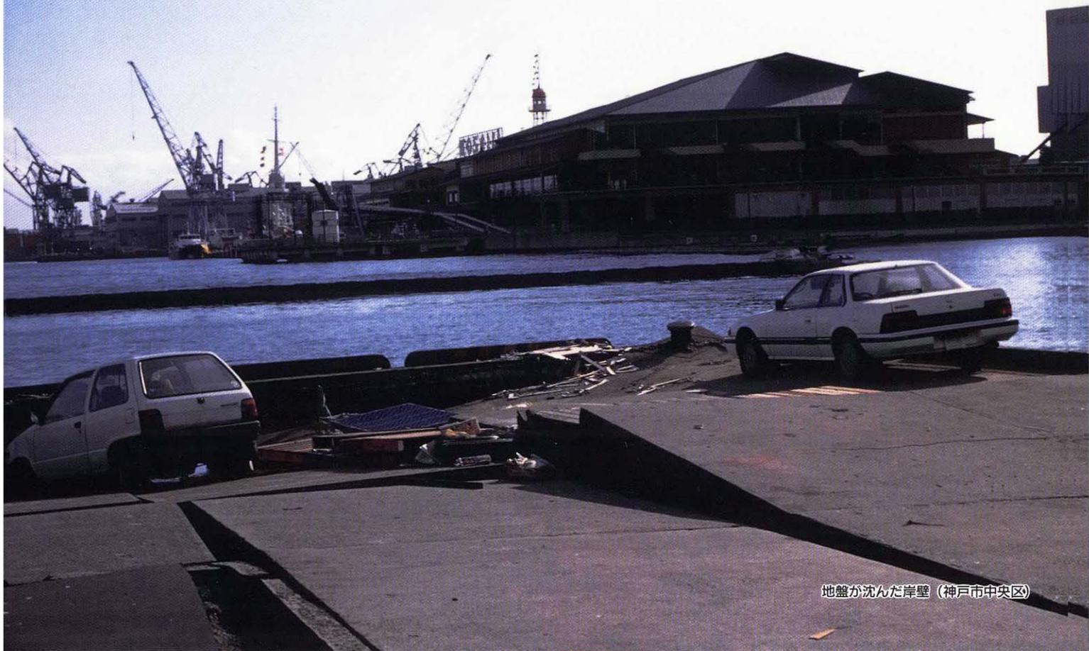
地盤が沈んだ岸壁（神戸市中央区）
