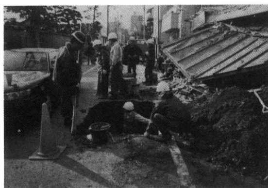
千葉県水道管工事協同組合による復旧工事の様相
