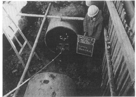
写真-2 管内テレビカメラによる管内調査
