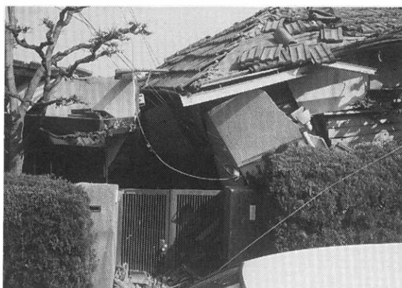
参考写真-5 倒壊家屋
