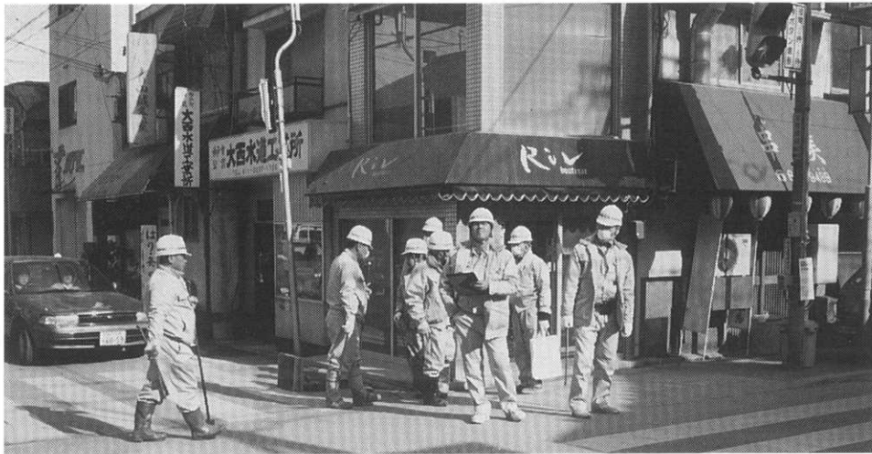
本管漏水調査工
