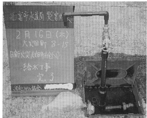
写真-2 仮設給水栓設置工事（ハンドル付止水栓使用）
