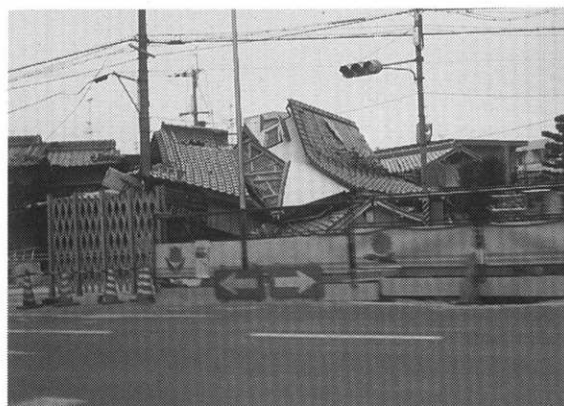
参考写真-4 倒壊家屋
