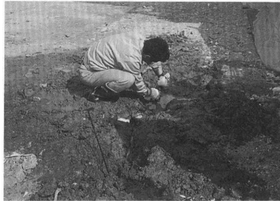
写真一 給水管栓止め
