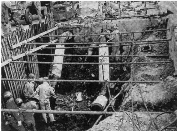
写真-8 深江大橋橋台背面取替復旧
