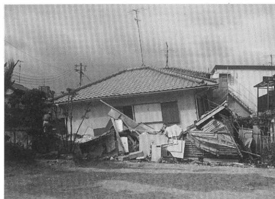
参考写真-2 倒壊家屋、2階立1階無し
