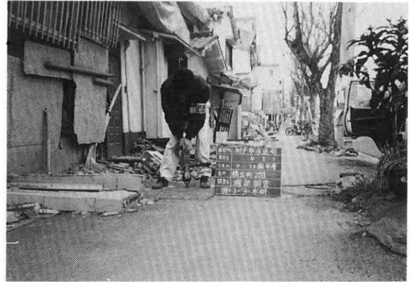
写真－2 確認調査
