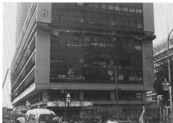
写真-2 神戸市庁舎2号館（水道局が6階部分に入っていた）
