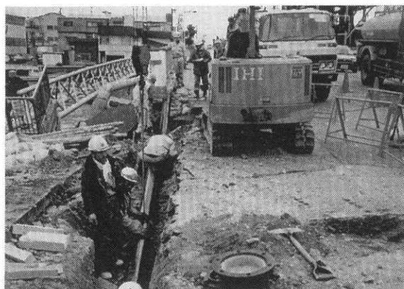
写真－1 荻藻橋仮配管
