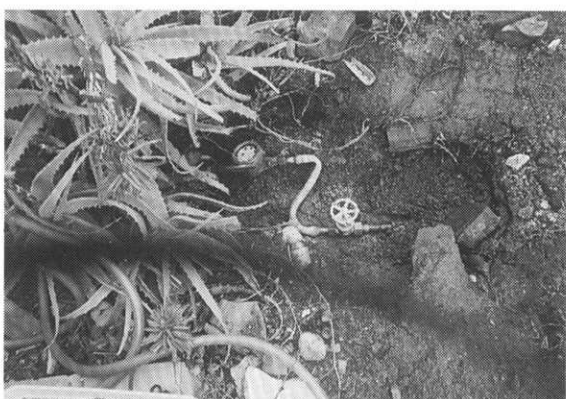
写真一五 止水栓交換、通水完了
