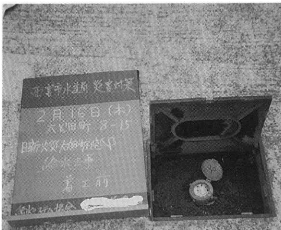
写真-2 仮設給水栓設置工事（ハンドル付止水栓使用）
