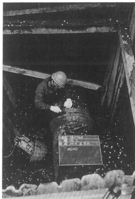
写真-6 印ろう継手の増締め
