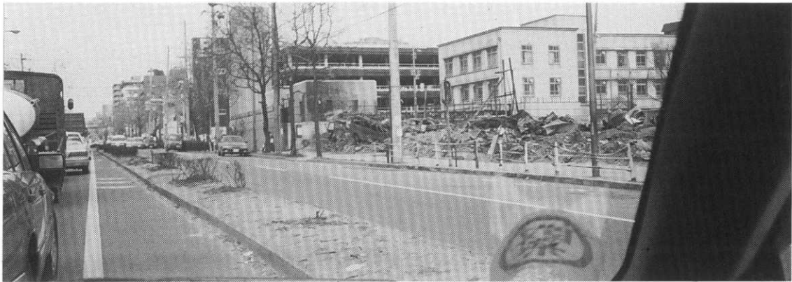
神戸水道局西部センター付近の災害状況
