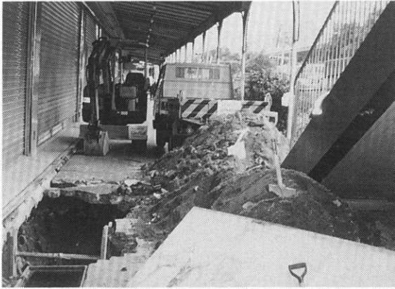
写真-3 東京都水道局による漏水修理現場
