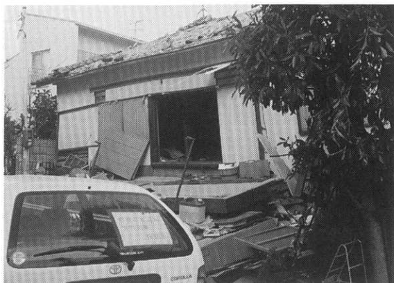
参考写真-1 倒壊家屋、2階立1階無し
