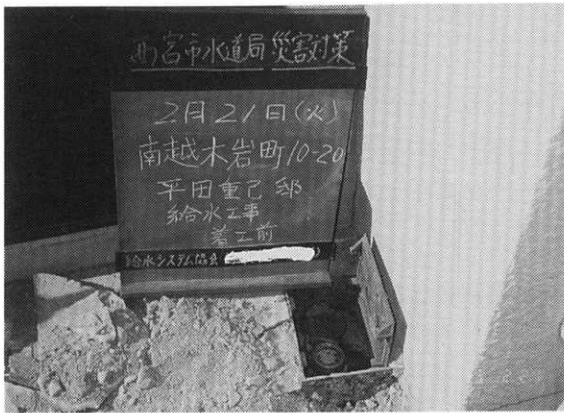
写真-1 仮設給水栓設置工事（既設給水栓使用）
