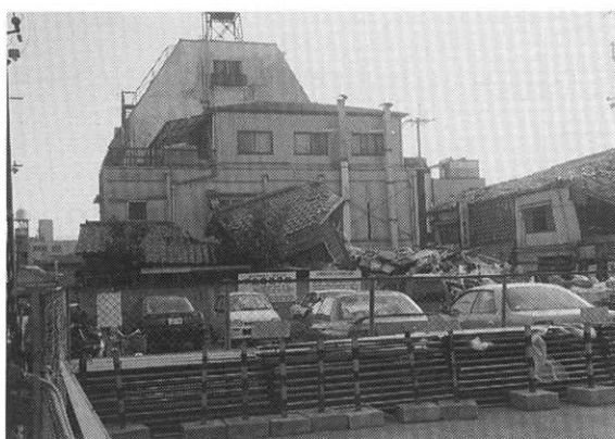
参考写真-3 倒壊家屋
