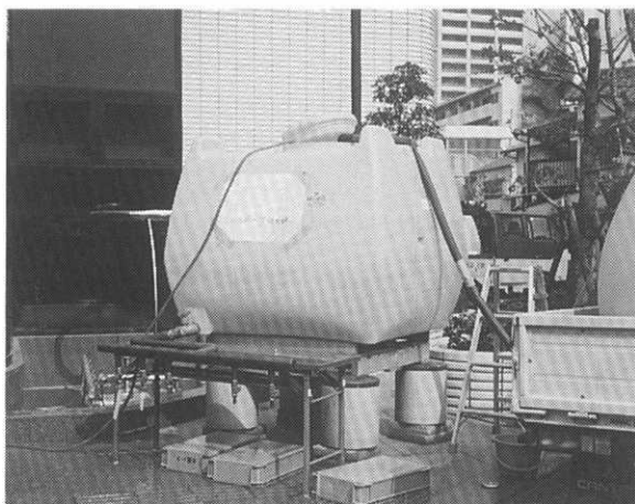
西宮市水道局前の給水タンク
