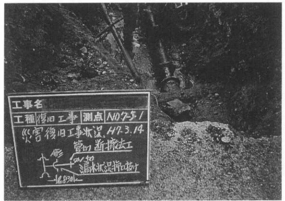
写真-4 補修状況
