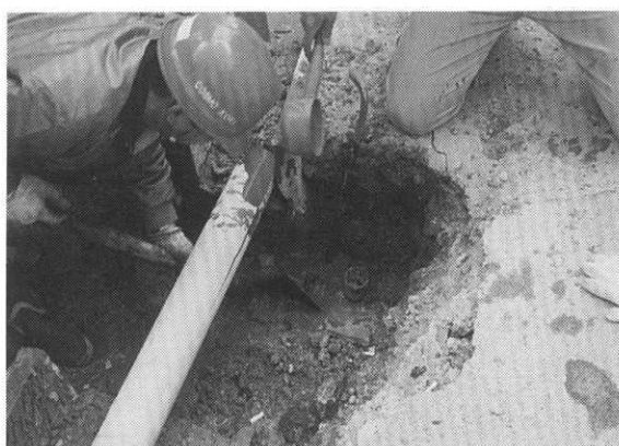
写真一六 給水管漏水修理
