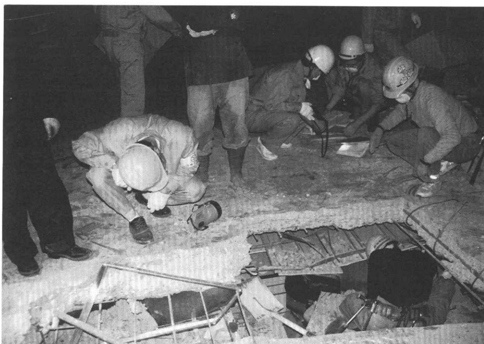
写真5-1 水道局フロアの掘出し作業
