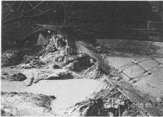
中池・下池間堤体破壊状況
