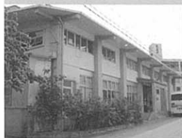
南風原文化センターの外観 撮影＝菅祥明
