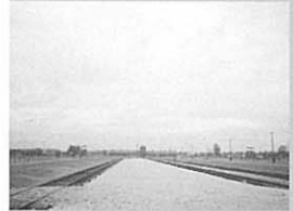
引き込み線からゲートを望む 撮影＝菅祥明
