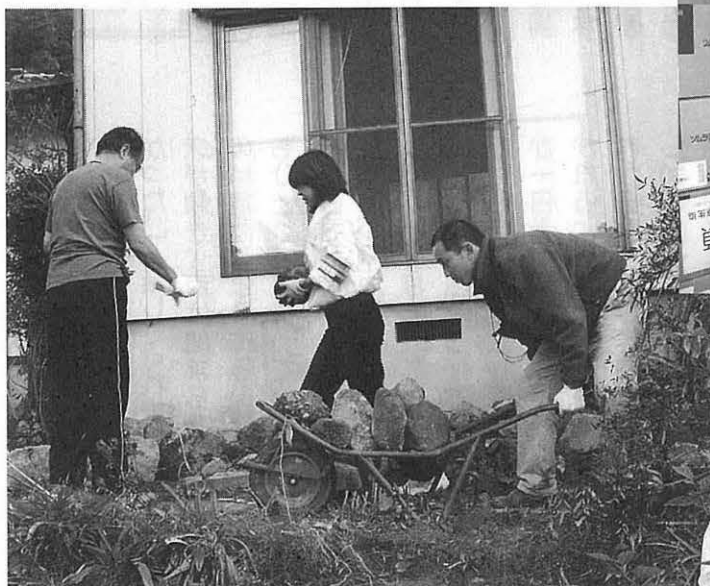
▲崩れた石垣の石を取り除くボランティア
