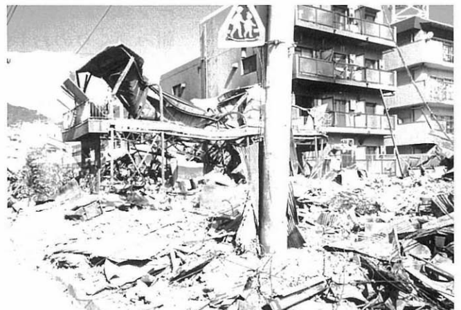
1.17震災時に火災が発生し焼失した家屋
