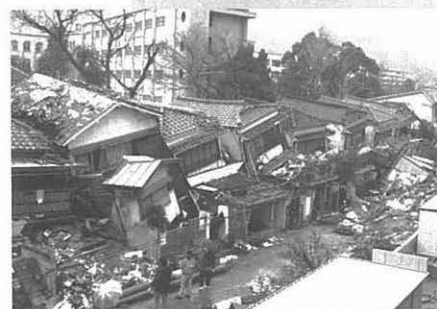
神戸市内の民家倒壊
