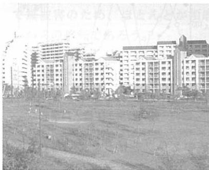
写真4 西神南の市営住宅
