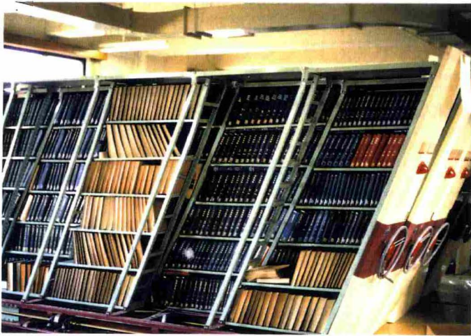
傾斜破損した集密書架
