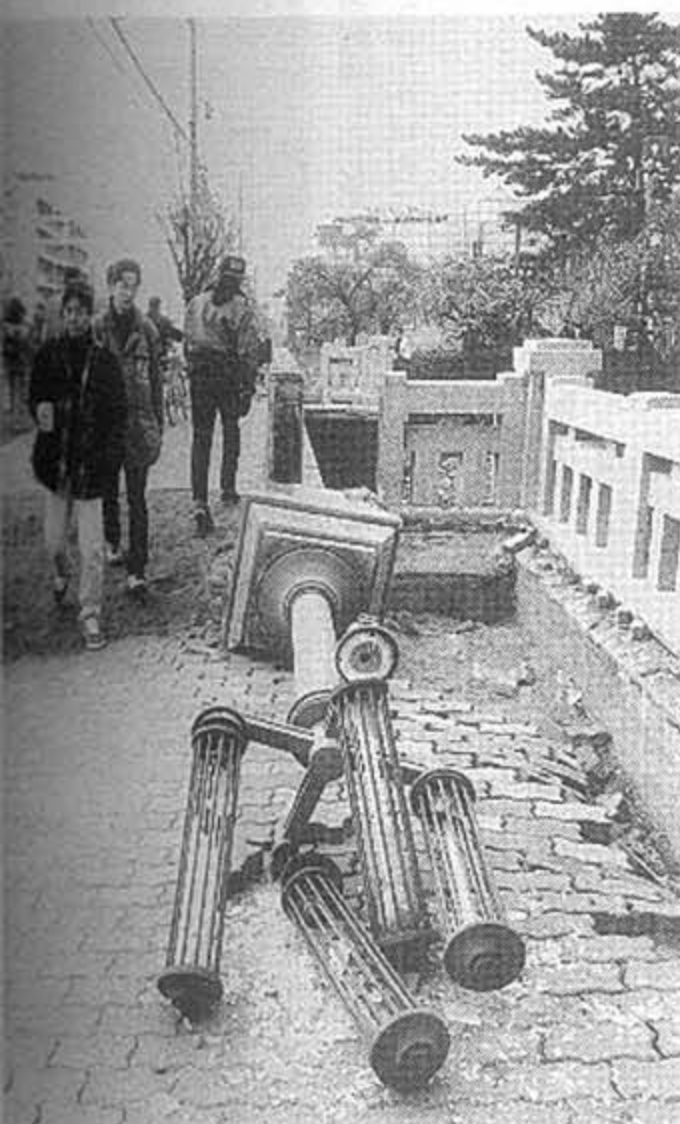
阪神国道の橋の照明塔も倒れて砕けた
