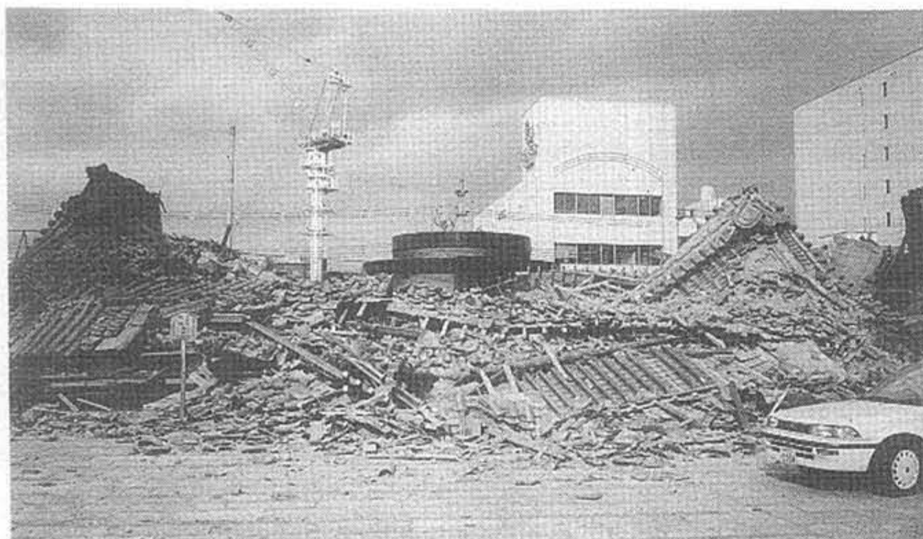
原形をとどめず崩れ落ちた西宮市の東福寺派・茂松寺本堂
