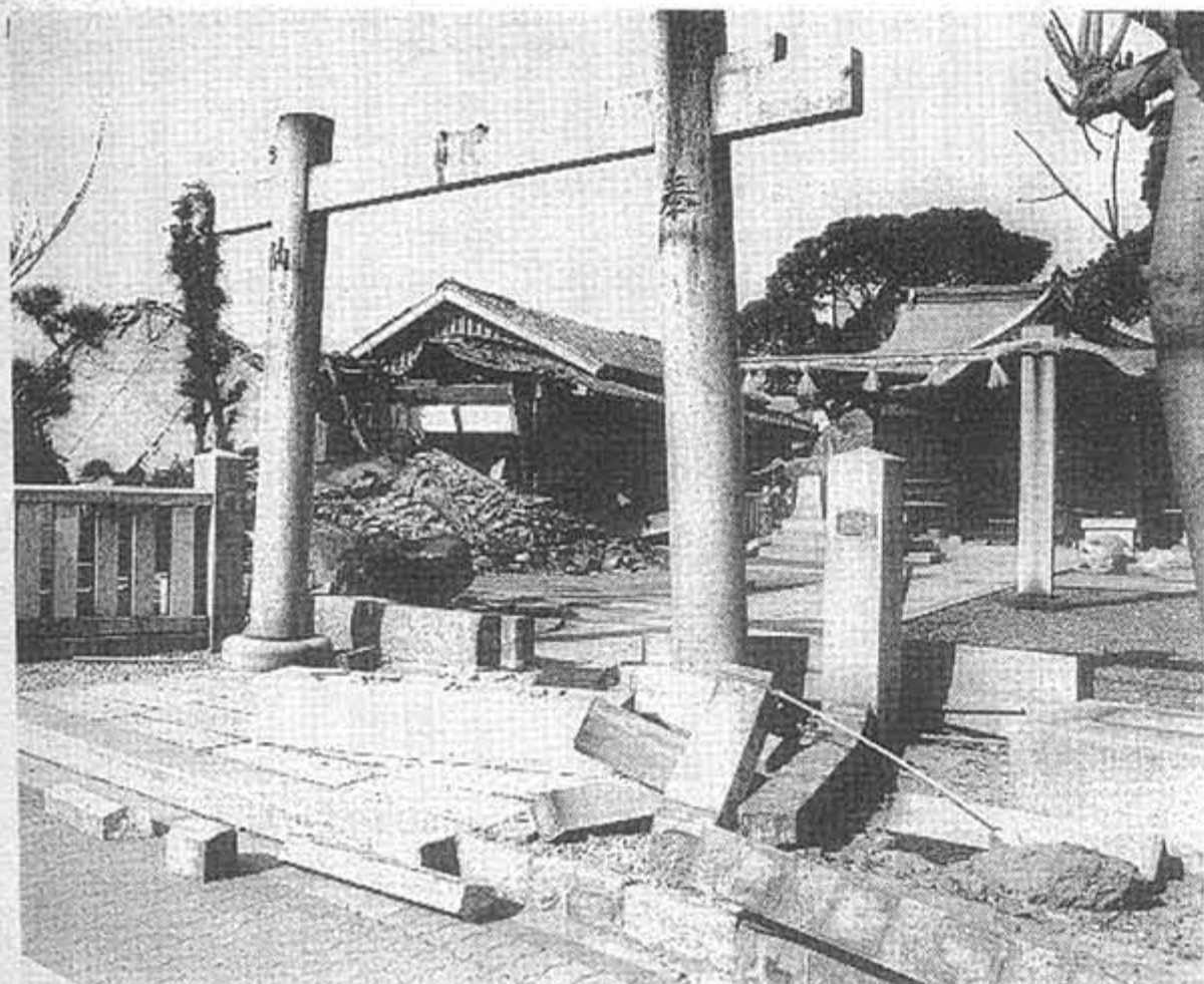
兵庫県神社庁長の岡田替夫宮司が奉仕する西宮市・八幡神社も壊滅状態
