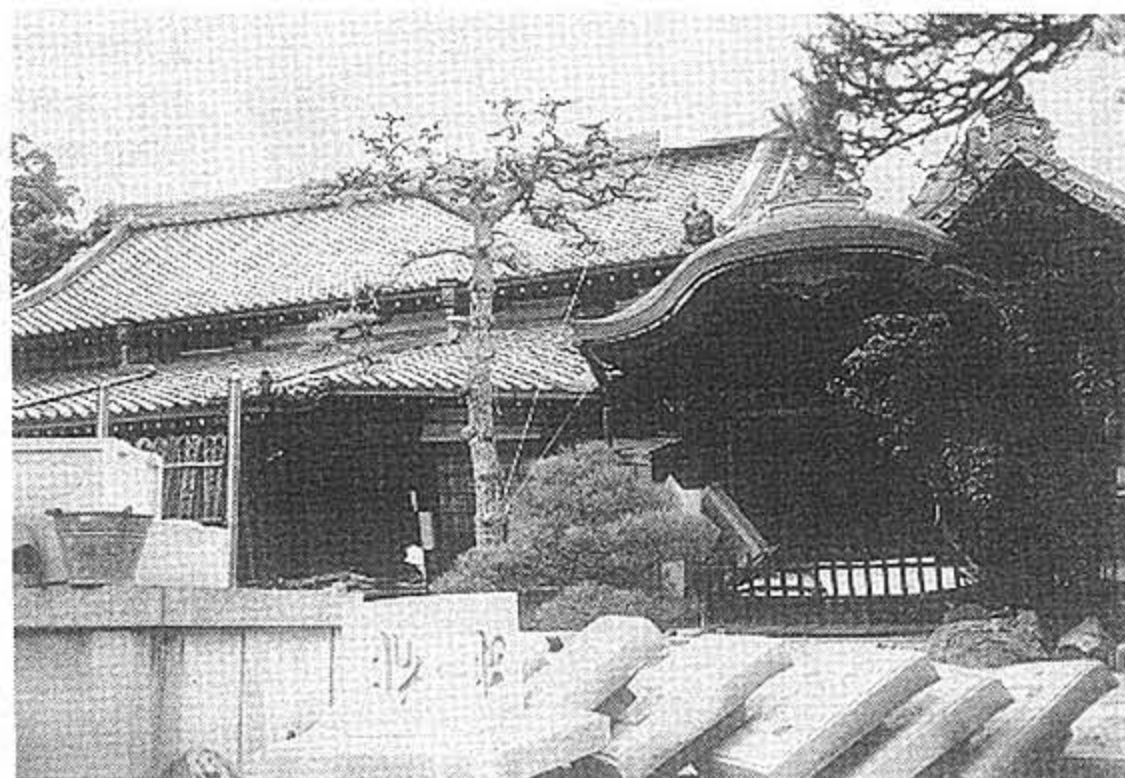
神戸市長田区西山町の南禅寺派福聚寺では、塀は全壊して、十三重石塔も倒壊。倒壊を免れた本堂・庫裡も使用不能の状態に
