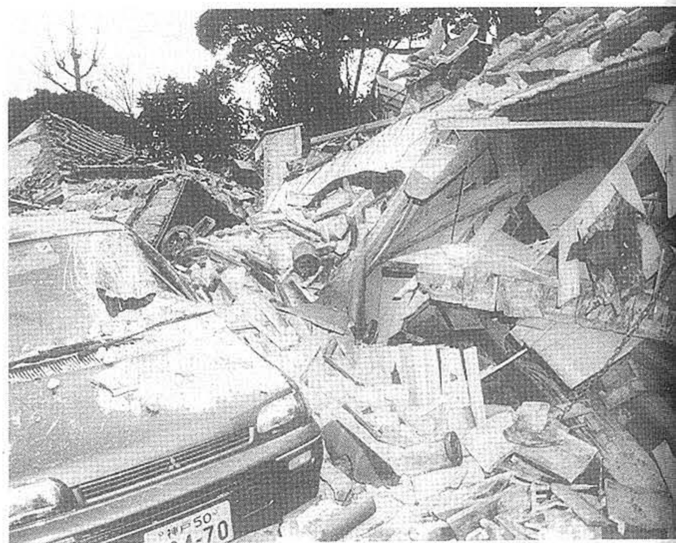
本堂、山門、経堂、鐘楼が倒壊、参道の自動車を押しつぶした尼崎市の真宗大谷派圓受寺
