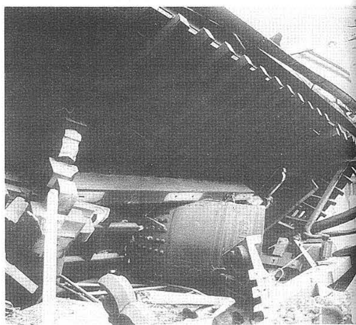
建造後二百年以上経つという鐘楼堂が倒壊、瓦礫に埋もれた浄土真宗本願寺派万徳寺＝兵庫県尼崎市＝
