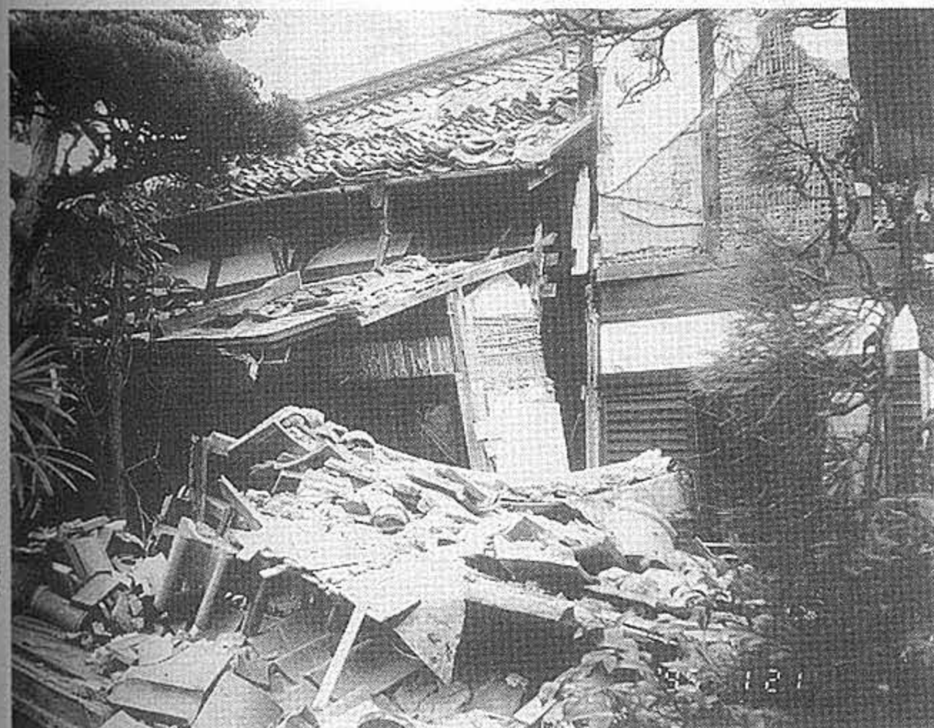
兵庫区の妙心寺派・松崎寺の本堂、庫裡は崩壊して手がつけられない状態
