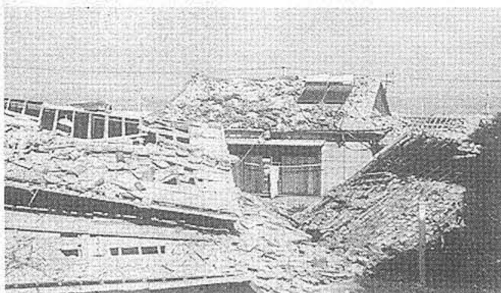
淡路島北部の民家は瓦がすべてはがれている
