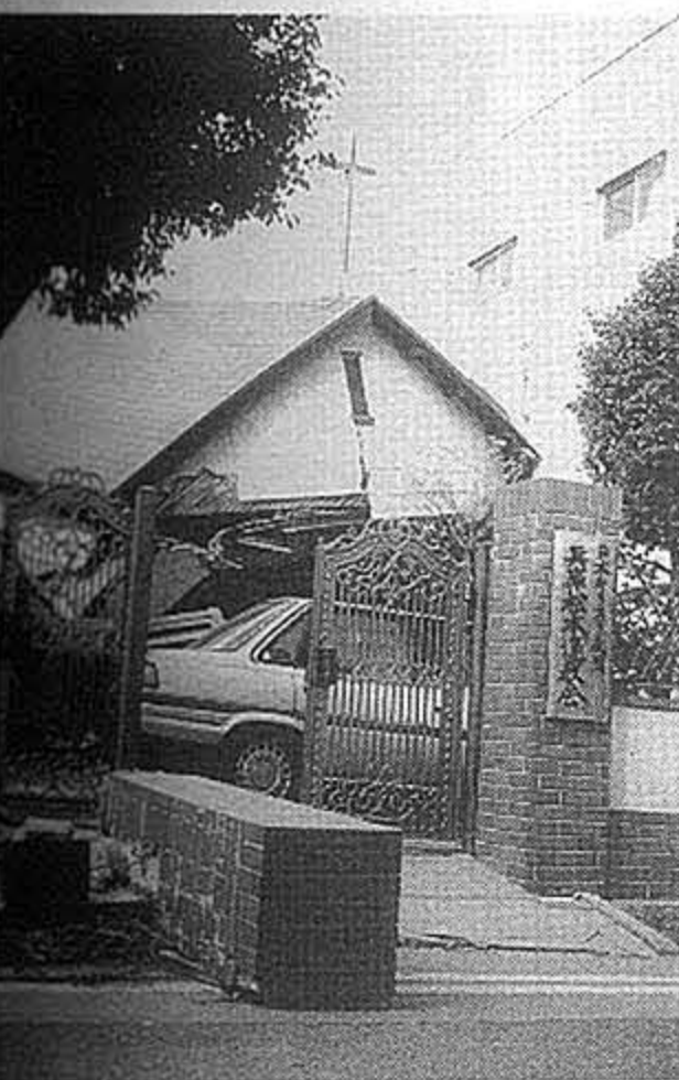
兵庫区松本通の日本キリスト教団兵庫松本通教会は倒壊。門の柱も倒れた
