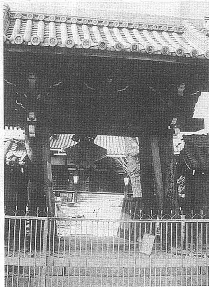
鐘楼が倒壊、庫裡と山門も半壊するなど大きな被害を受けた本願寺派徳照寺（廣岡行信住職・神戸市中央区）。頑丈な山門が傾き今にも倒れそうになっている
