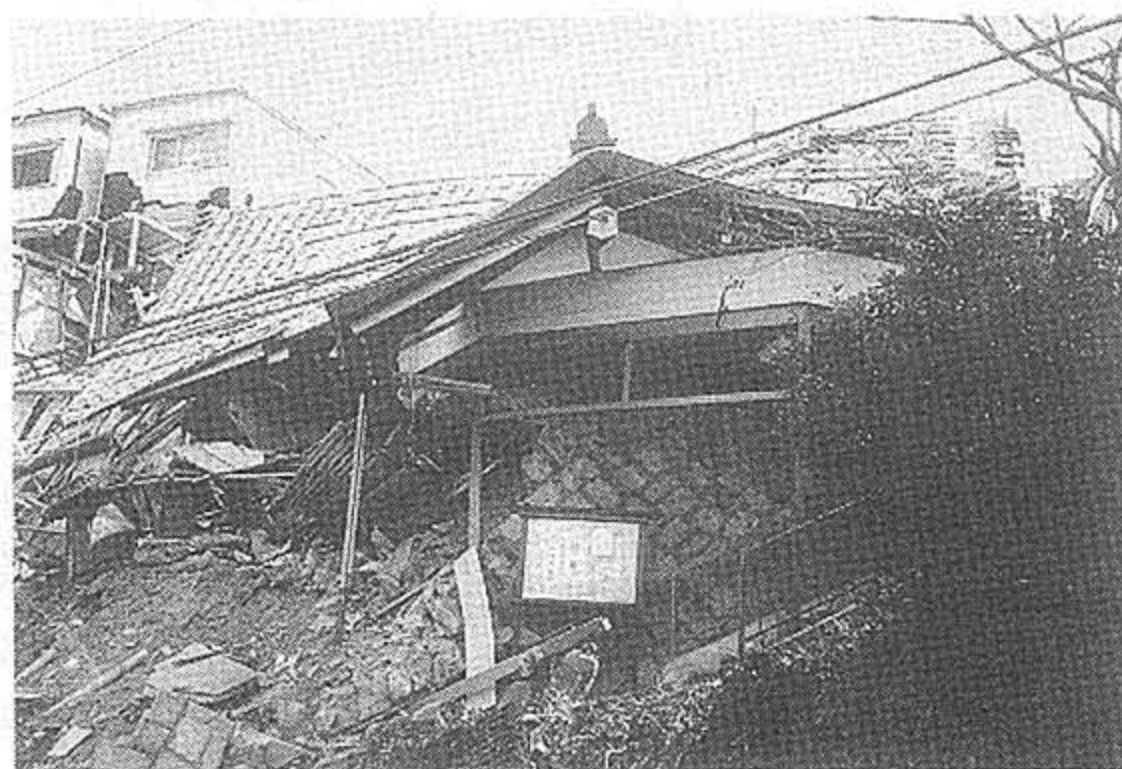
日蓮宗妙徳寺（福田淳弘住職、兵庫区会下山町）は本堂が神戸電鉄有馬線（湊川―長田間）の線路上に倒壊、落下した
