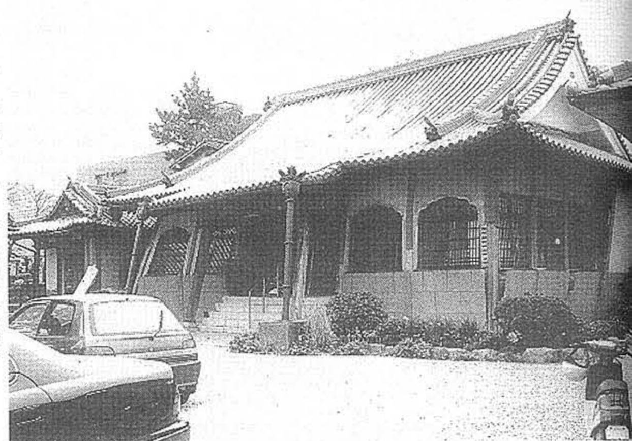
兵庫県西宮市津門西口町の浄土宗昌林寺（花木亨純住職）では本堂が大きく傾き、山門も全壊
