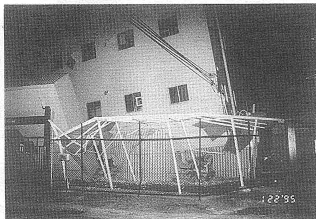
念法真教の神戸念法寺（兵庫区）はほとんどの建物が崩れた
