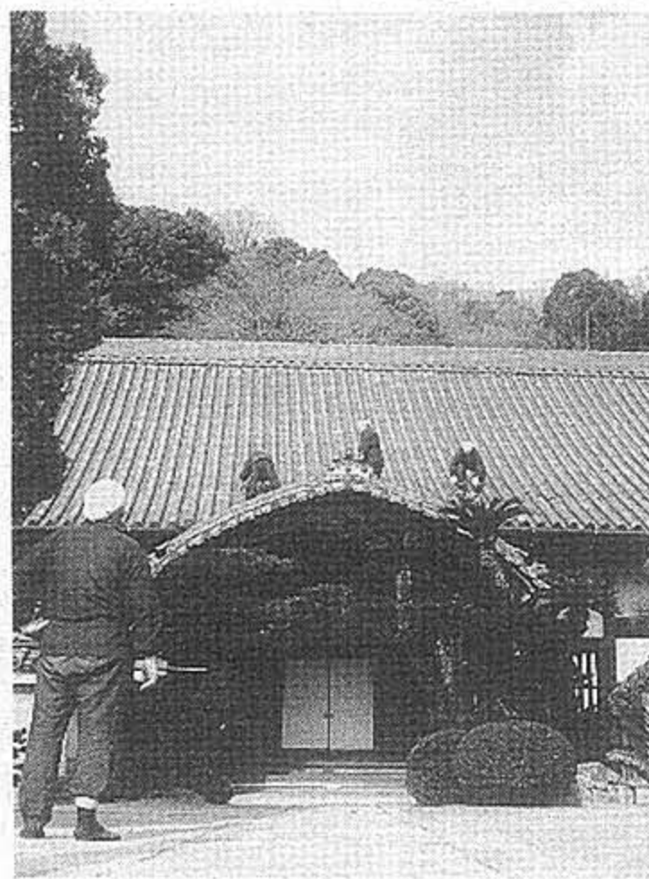
崩れ落ちた屋根瓦を補修する雲水たち（兵庫区の妙心寺派祥福寺で）
