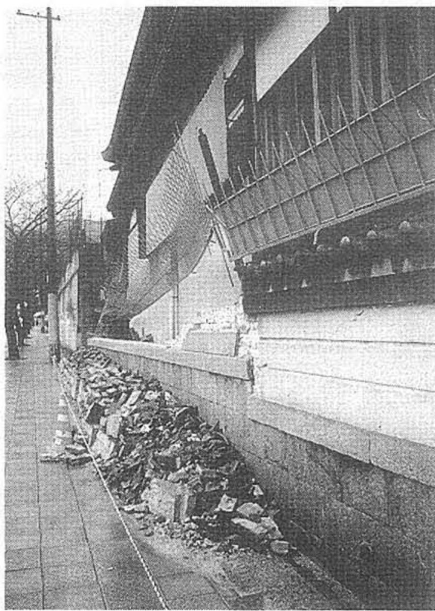
新神戸駅から三筋下った角にある中央区の曹洞宗東福寺は外塀が崩れ(写真①)、六本柱の鐘楼堂は足が外れて倒れる寸前(写真②)。総檜づくりの見事な本堂も、歪んでしまった
