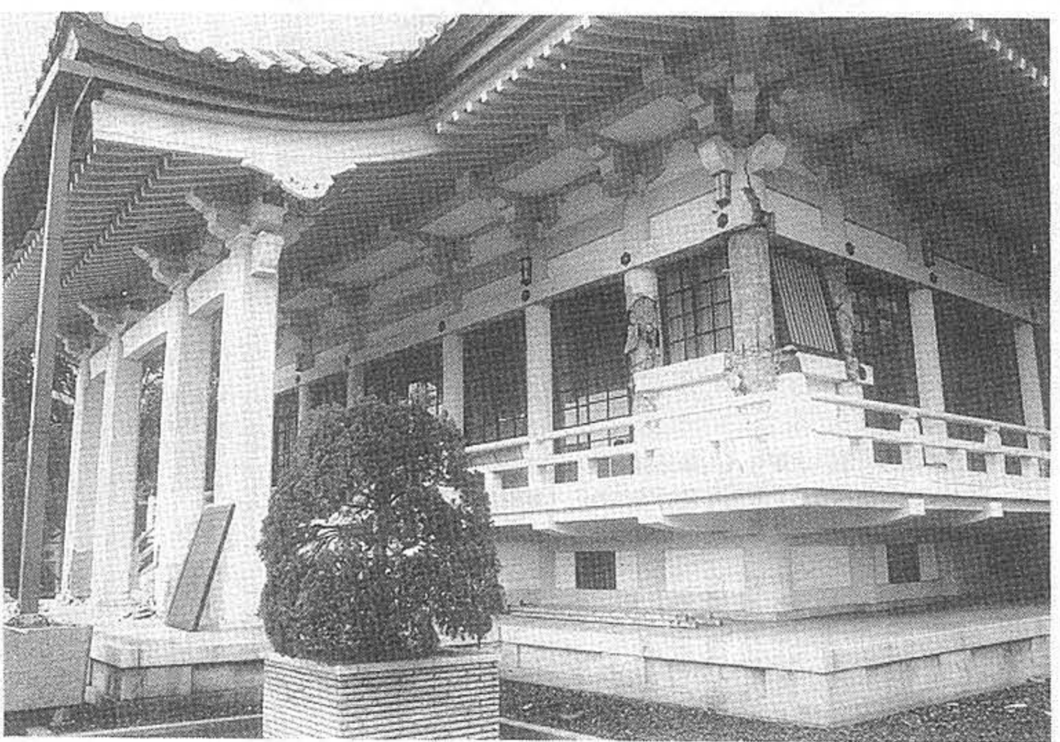
兵庫区会下山町の高台にある本門佛立宗の本法寺は大伽藍の外形をとどめているが本堂・庫裡の内部は損傷が激しい
