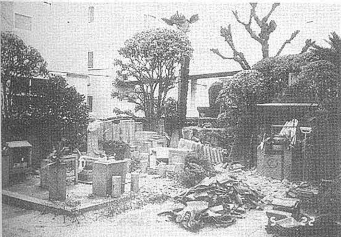
神戸市中央区の日蓮宗本妙院(大塚泰詮住職)兵庫東部宗務所長)は本堂屋根・内部に被害を受け、さらに浄行堂・寫経塔は崩壊した
