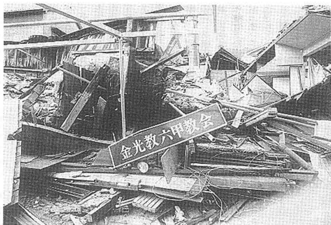
金光教六甲教会（神戸市灘区）は全ての建物が全壊、御祈念中だった沢田教会長も下敷きになったが幸い助かった
