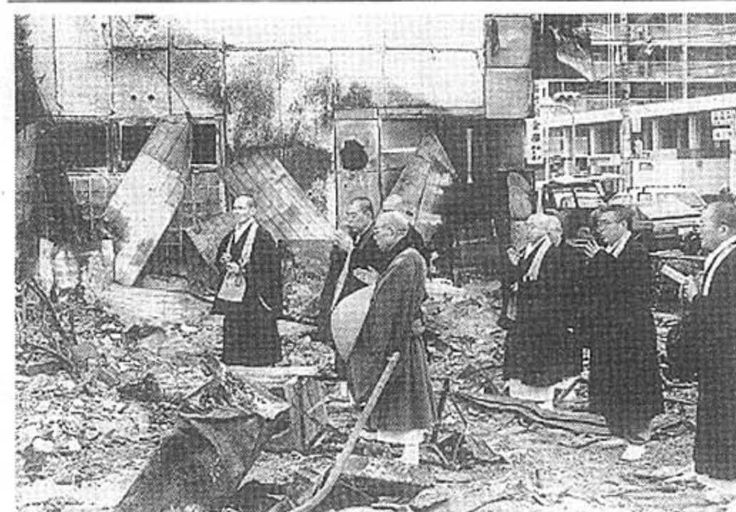
瓦礫の山に分け入り犠牲者供養の諷経を行なった
