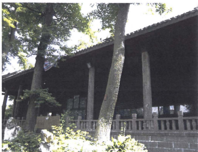
▲写真1 成都市武侯祠孔明殿の修復の様子 （壁をつみなおしている。6月30日見学。）
