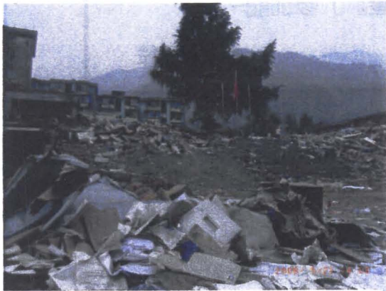
文書が散乱する庁舎の倒壊現場 (アジア防災センター提供)
