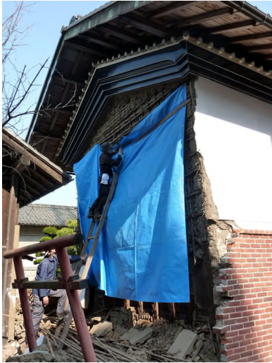
▲土蔵の崩落部分をブルーシートで応急処置
