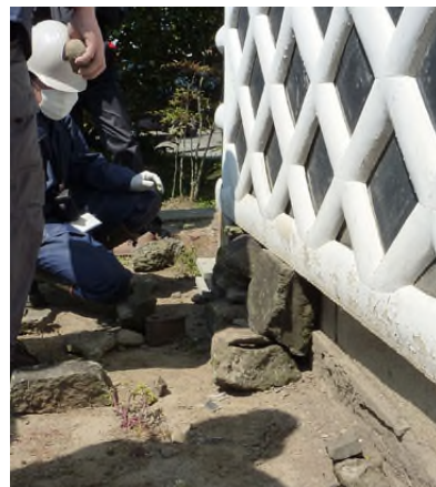
▲土蔵の剥離した壁土をブロックで応急処置
