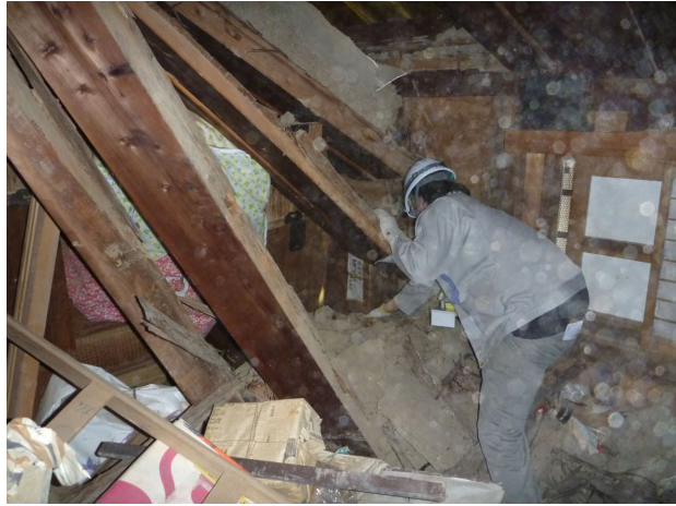
▲大破した土蔵での救出作業
