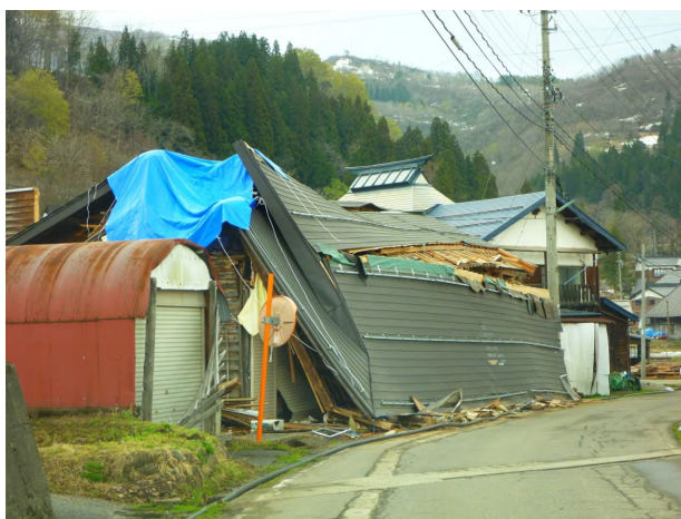
▲全壊した公民館
