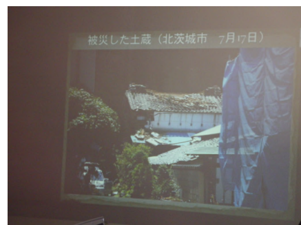
▲報告スライドから北茨城市の被災した土蔵＝同
