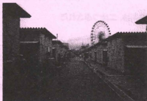
ポートアイランド南の埋立地に建てられた 仮設住宅・北側に遊園地の観覧車が見える。
