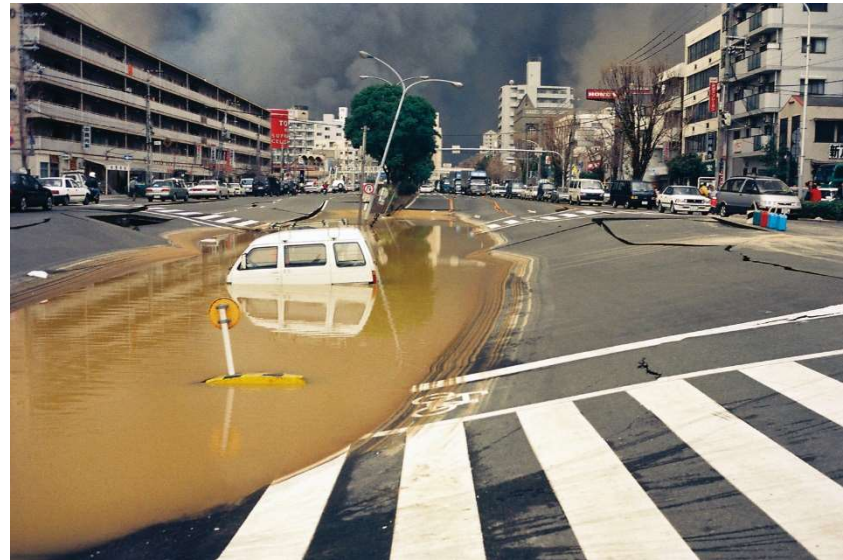
大開駅地上部(兵庫区水木通7丁目)
