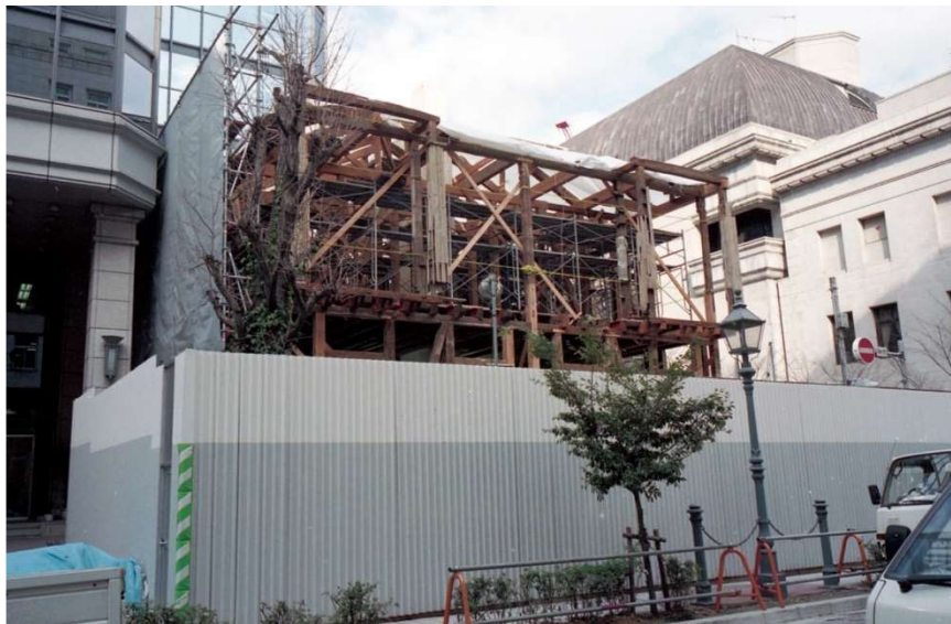
再建工事が進む十五番館(1997年2月5日)
