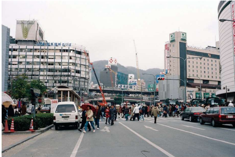
そごう前のフラワーロードから三宮交差点の南側周辺を写す 左には5階が座屈倒壊した交通センタービル、右は三宮ターミナルビル 1995年2月4日(中央区三宮町1丁目・雲井通8丁目)
