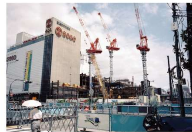
新国際会館の建設、骨組が上がりはじめた 1997年8月15日
