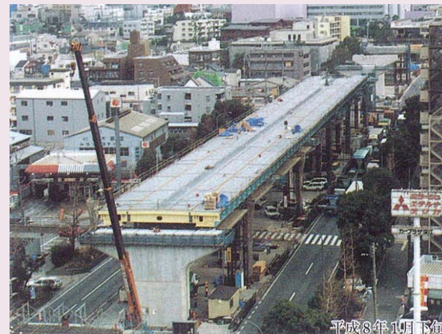
写真6 ピルツ区間の復旧状況
