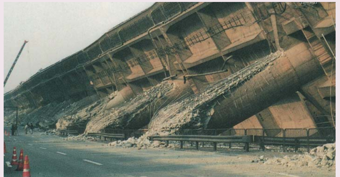
写真1 ピルツ構造区間の倒壊の状況
