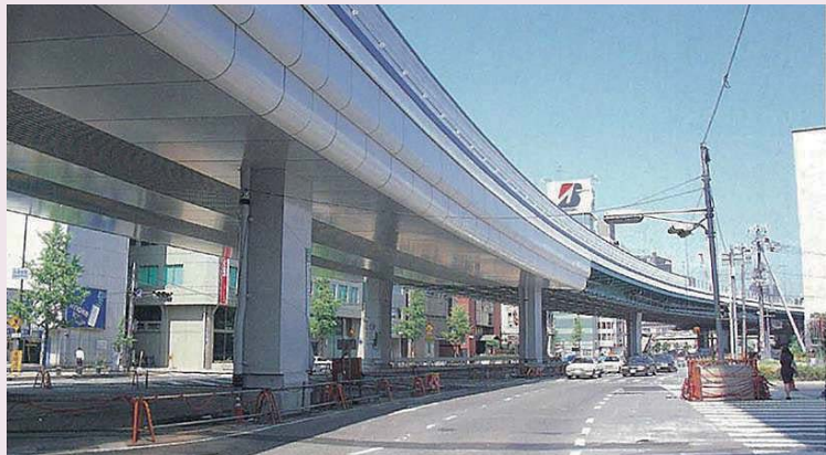
写真3 19径間連続ラーメン橋構造（弁天工区）
