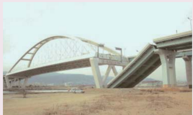
写真4 西宮港大橋の隣接桁の落橋
