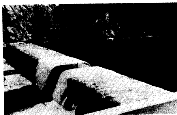
写真2 台形せき（手前にある刃形せきより越流頂は0.3m高い。中央は角落し。）
