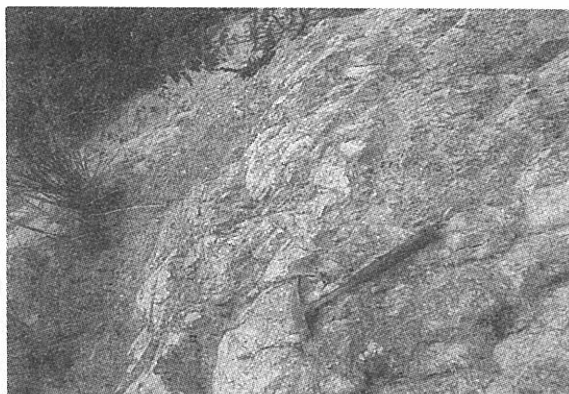
神戸市西部 K-3 高取山町1丁目 白色の細脈の斜面に沿って崩壊が生じている。
