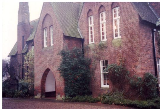
図4 正面から見た〈レッド・ハウス〉。
