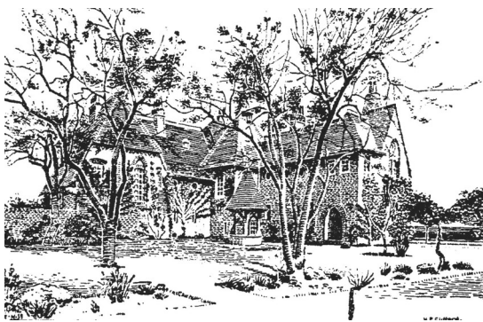
図6 裏庭から見た〈レッド・ハウス〉の全景。ウィリアム・モリスは、ジェイン・バーデンとの結婚に際し、新居の設計をフィリップ・ウェブに依頼。こうして完成したのがこの〈レッド・ハウス〉で、1860年に入居。
