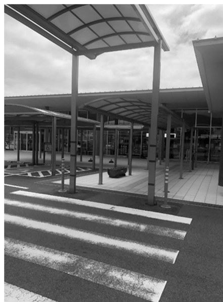
図3：道の駅すさみ（著者撮影）
