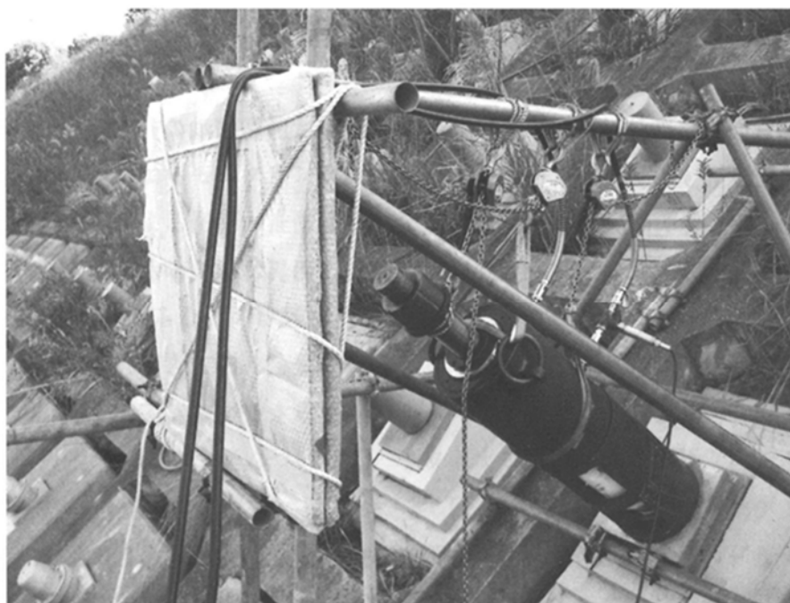
写真-2.3 リフトオフ試験の実施状況 2)
