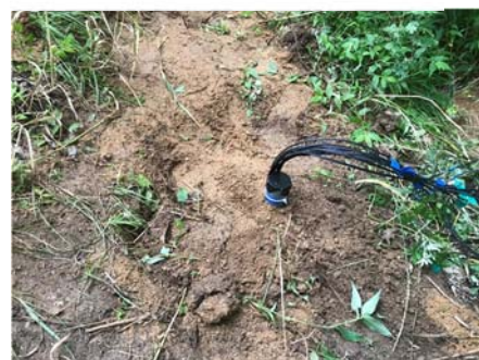
(c) 埋設完了
