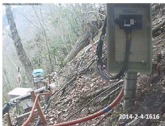
(c) 設置状況
