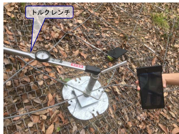
(b) トルクレンチによる軸力の導入
