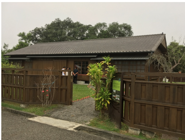
写真8 八田與一記念公園内の修復後の日本式宿舎 筆者撮影（2017年11月12日）
