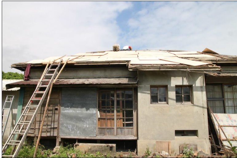
写真 15 修復前の鹿野区役場 古屋。老樹。鹿野區役場（2012 年 12 月 25 日）
