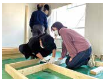
写真1. 作業風景 (左・天井のペイント、中央・フロアタイル貼り、右・家具製作)
