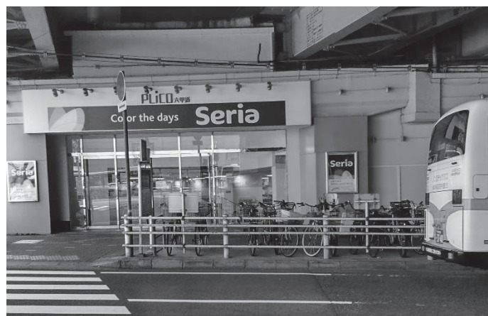
写真7 中央館から見た西館
