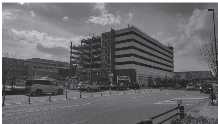
写真4 阪急西宮ガーデンズの駐車場専用棟
