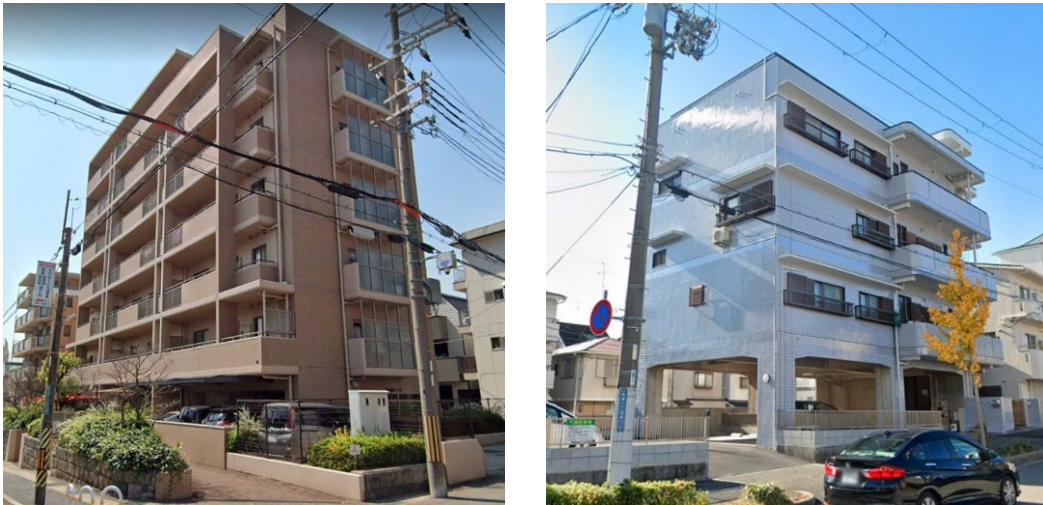
図－1.2 ピロティ形式の住宅建築の例（@Google Street View 2023）
