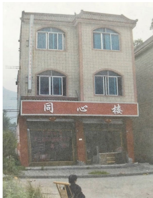
図－1.19 事例② 3階建て1階は店舗のピロティ形式建築物[1-9]
