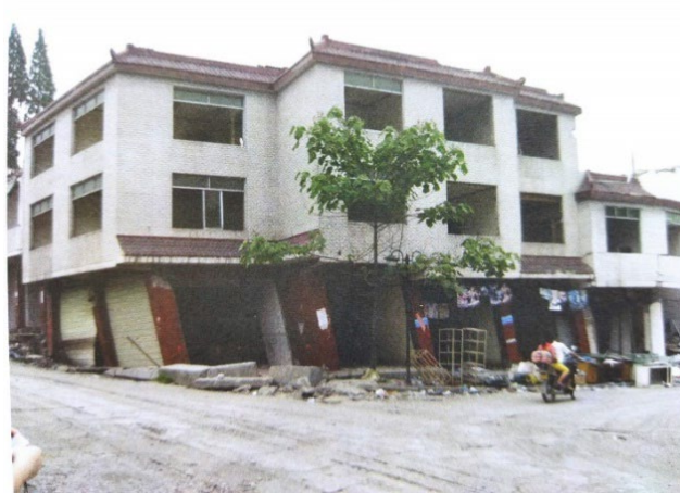
図－1.18 事例① 3階建てピロティ形式の建築物[1-9]
