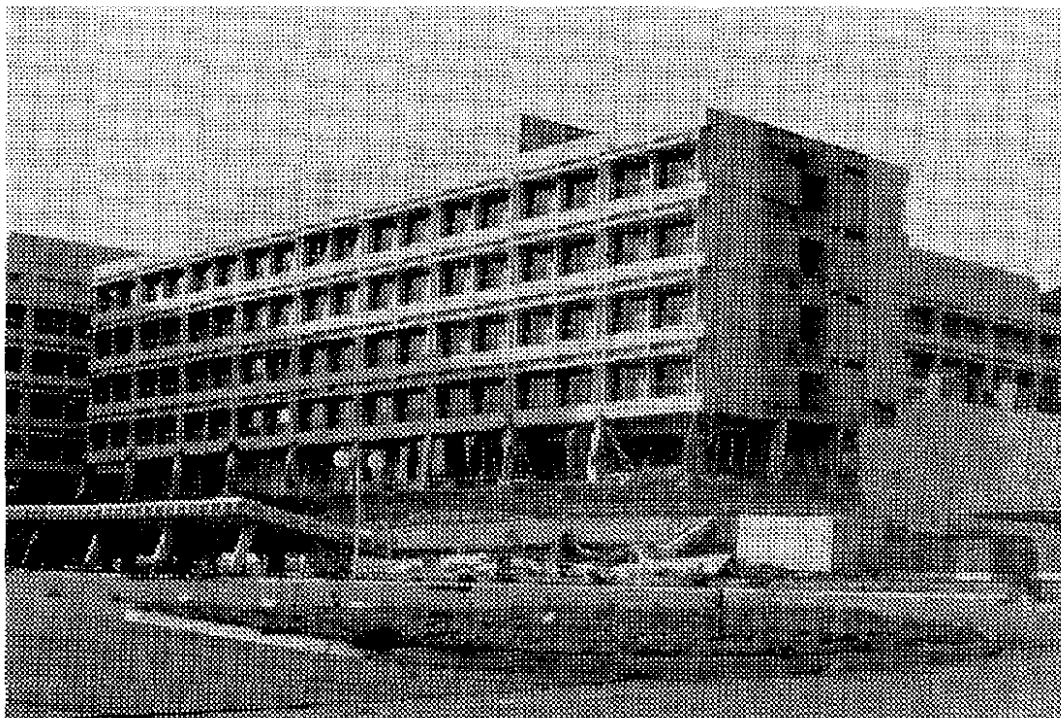
図-1.14 旧 Olive View 病院の被災した様子[1-6]
