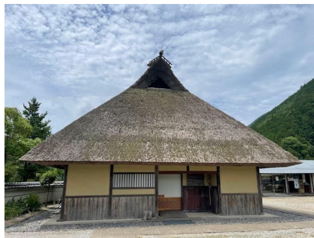
第10図 施設内に保存されている旧梶谷家住宅
