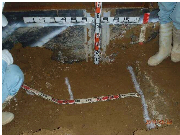
図 4-17 発生クラックの掘削調査状況
