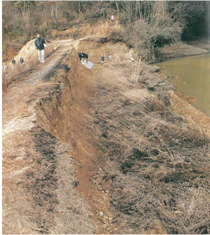
図 3-10 地震により法面が滑落したため池被災（二六池，兵庫県撮影）
