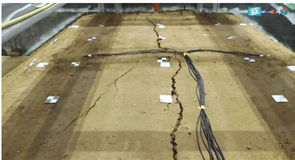
図4-15 レベル2地震動加震後の堤体天端状況
