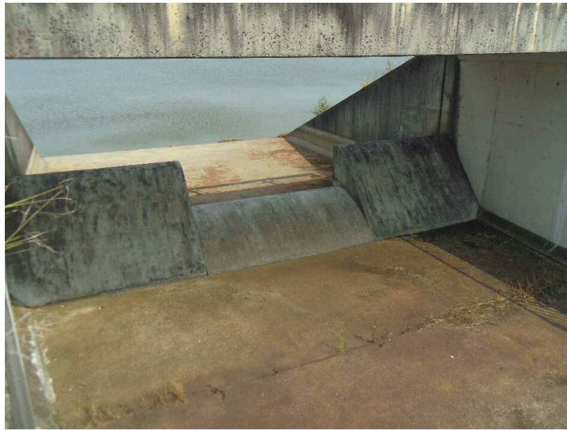
図 2-9 洪水調節機能を備えた洪水吐の施工例（加古大池，兵庫県撮影）
