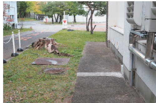
図3 館外の排水管処置 (右写真で、左側の切株手前に見えるマンホールが排水管の合流箇所。地下の排水管が植物根で排水不良の状態であった。)
