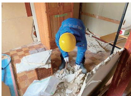
家の内壁を破壊している様子
