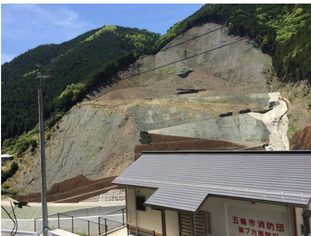
第5図 五條市大塔町宇井からみた2011年紀伊半島大水害で生じた深層崩壊の斜面
