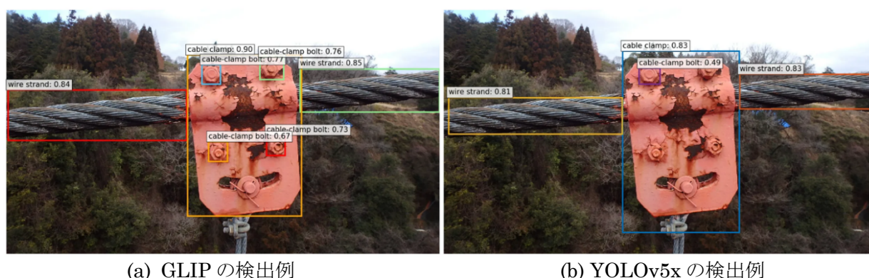
図 4 GLIP と YOLOv5x の部品検出例の比較。YOLOv5x は GLIP が正しく検出できているケーブルバンドボルトについて検出漏れを起こしている。
