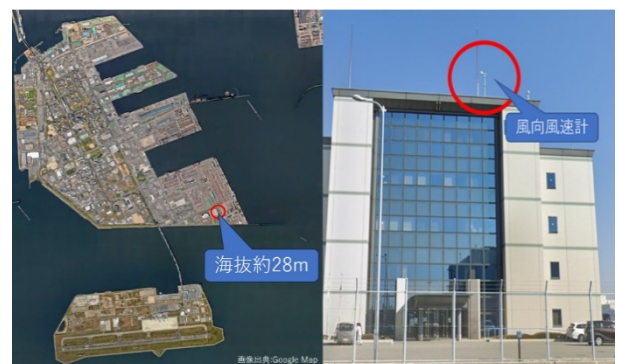
(b) 神戸港コンテナ埠頭の風速計設置環境
