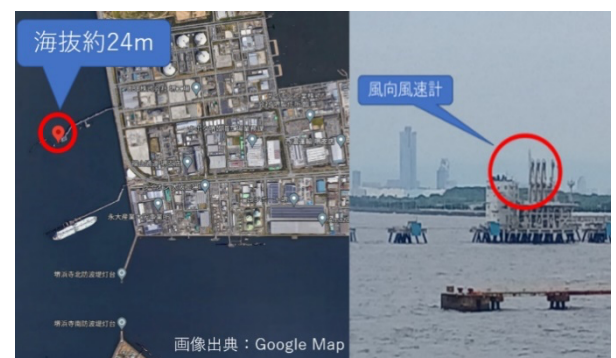
(c) 堺 LNG 栈橋の風速計設置環境
