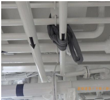
図 19 巻き付けたスプリングワイヤー 及びチェンブロック
