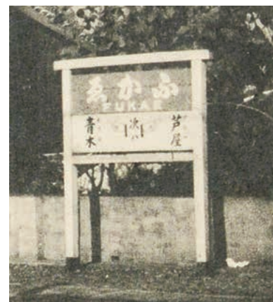
阪神電気鉄道ふか駅 明治38（1905）年4月 大阪―三宮間に開通
