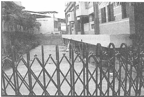
図-13 Bブロックの高層マンションの傾斜
