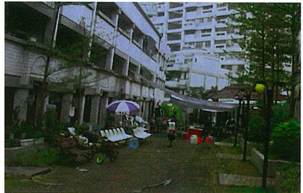
図-10 北端(左)マンションの傾斜(奥側:Bブロック)
