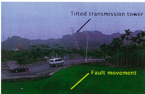
図-21 断層変位による高圧線鉄塔の傾斜
