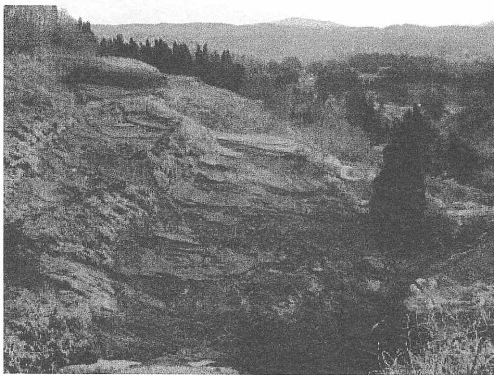
図 17 塩谷地区の地すべり移動体に見られるき裂群の様子。東方向を見る。
