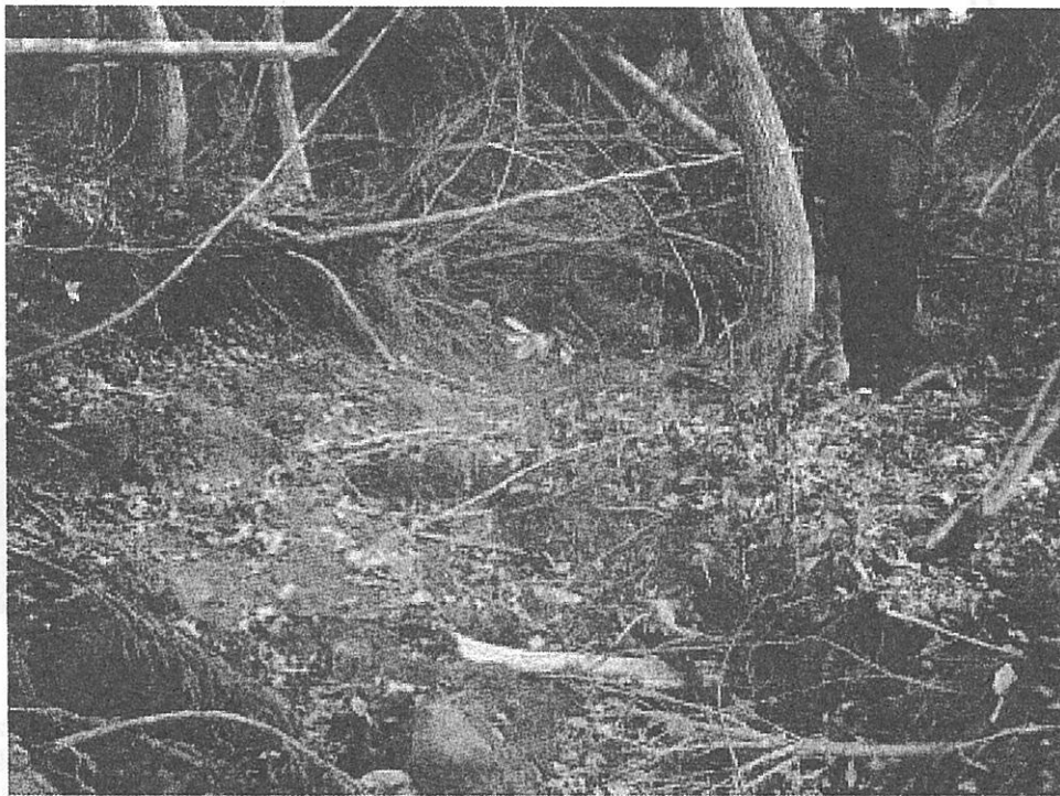
図 10 地すべり移動体に見られるき裂。小規模な地溝を形勢する。
