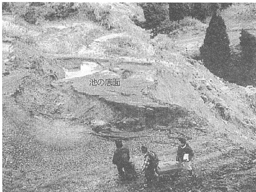
図 20 池の底面と道路の南東側（写真の右側）が滑落している。
