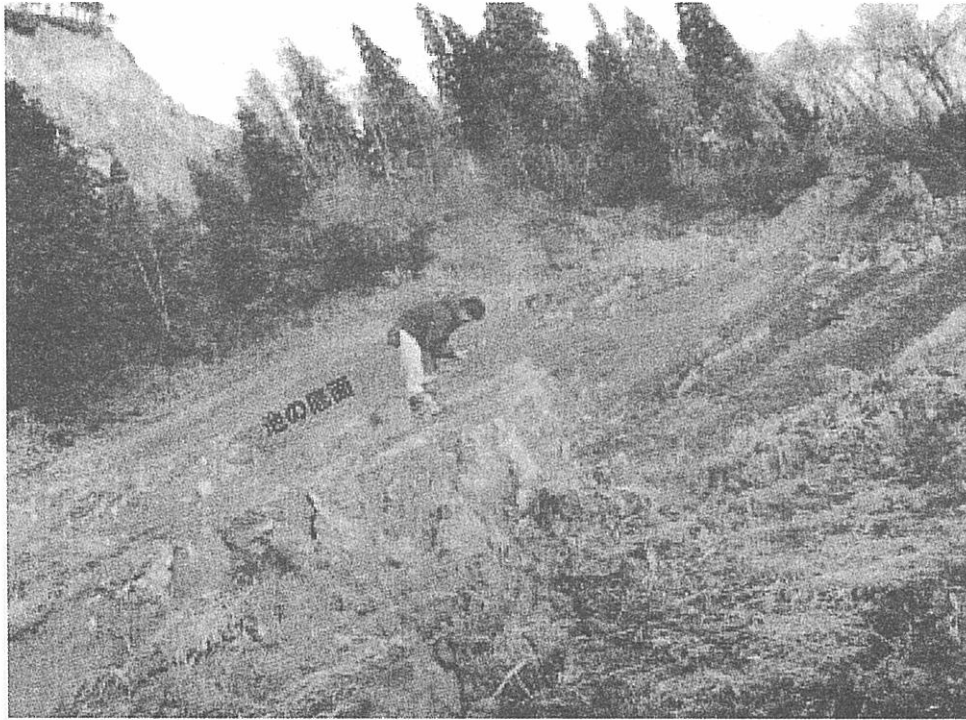
図 18 傾斜した地すべり移動体と形成されたき裂群. 北方向を見る. 地震前の池の底面が西側に 22^\circ 傾斜している.
